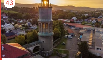
Zauhlovací a vodárenská věž Rumburská ul., Liberec
